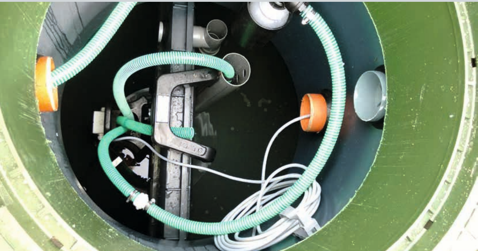
Draufsicht einer AQUATO® PUMP mit Trennwandaufhängung im Kunststoffbehälter
