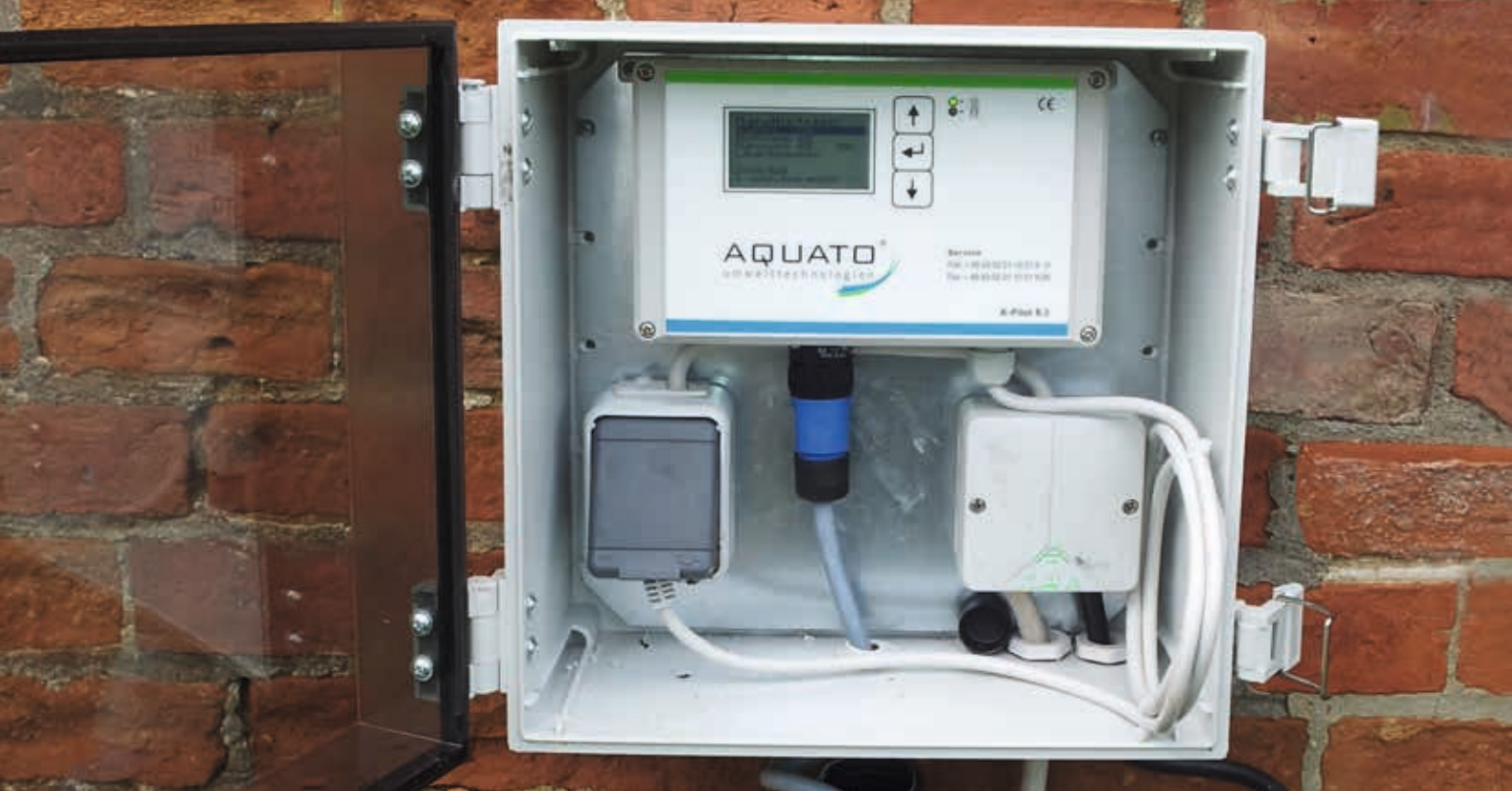
Wandschrank mit Steuerung 8.3 für AQUATO® PUMP
