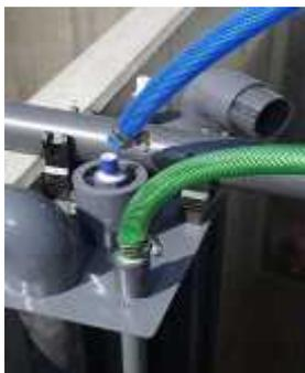
Die Belüftungseinrichtung und die drei Druckluftheber müssen an den Verdichter im Schaltschrank angeschlossen werden. Der Anschluss erfolgt über Schläuche mit 13 bis 19 mm Innendurchmesser je nach Anlagengröße.
