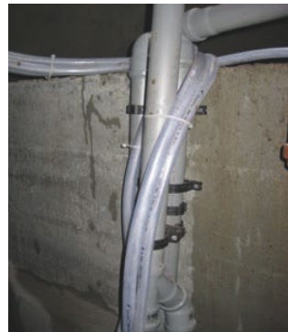
Schläuche an den Hebern nach oben geführt
