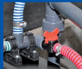
Mechanische Einstelleinheit für die Schlammrückführung , somit sind keine elektrischen Teile in dem Behälter erforderlich.
