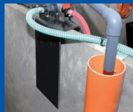
Halter aus Kunststoff Für eine einfache und schnelle Montage des Lufthebers.
