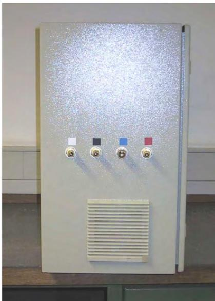
Abbildung 7 Seitenansicht des Innenschaltschranks mit den vier Schlauchanschlüssen
