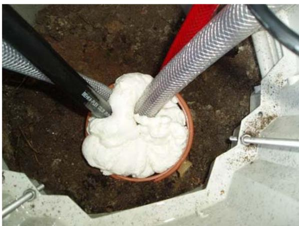
Die Schlauchoberflächen und Rohrwandungen sind mit Wasser grob zu reinigen und leicht mit Wasser zu benetzen.
