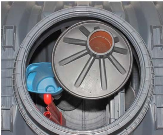
Auf das Standrohr zur Schlammentnahme wird die Abdeckung aufgesetzt.
